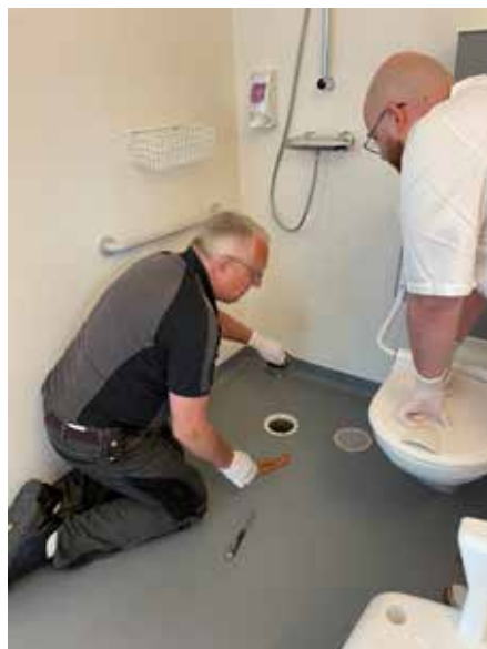
Bilde 4. Vi fikk god hjelp av rørlegger Rolf W. Berg i Teknisk avdeling til prøvetaking og kartlegging av avløpssystemet.
