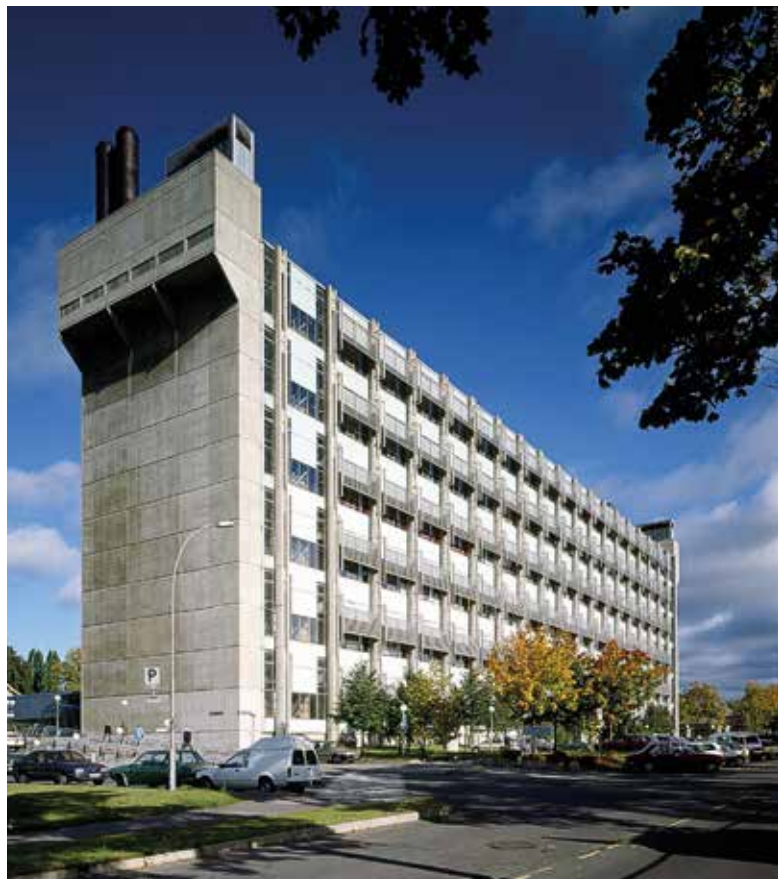
FREDET: Laboratoriebygget på Ullevål er fredet. I begrunnelsen for fredningen beskrives bygningen som «et eksempel på rendyrket modernistisk arkitektur der betongen eksponeres både som konstruktive og dekorative elementer».
